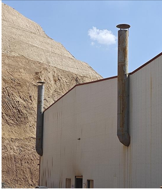
破碎车间排气筒
