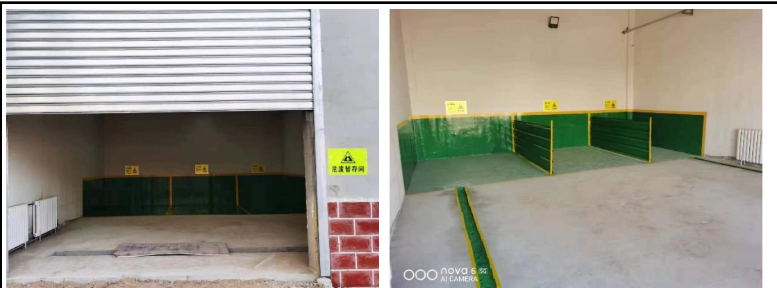
危废暂存间建设现状
