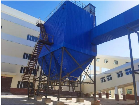
锅炉房配套建设布袋除尘器
