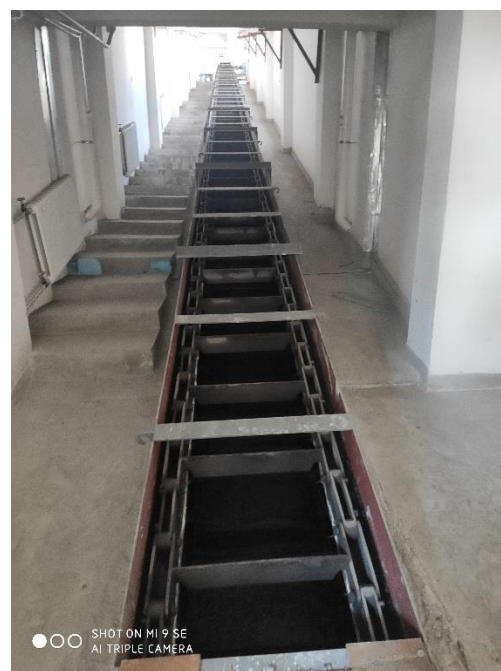
锅炉房炉渣输送系统
