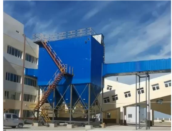
锅炉房配套建设布袋除尘器
