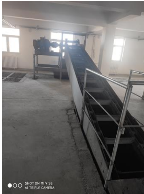
锅炉房炉渣输送系统
