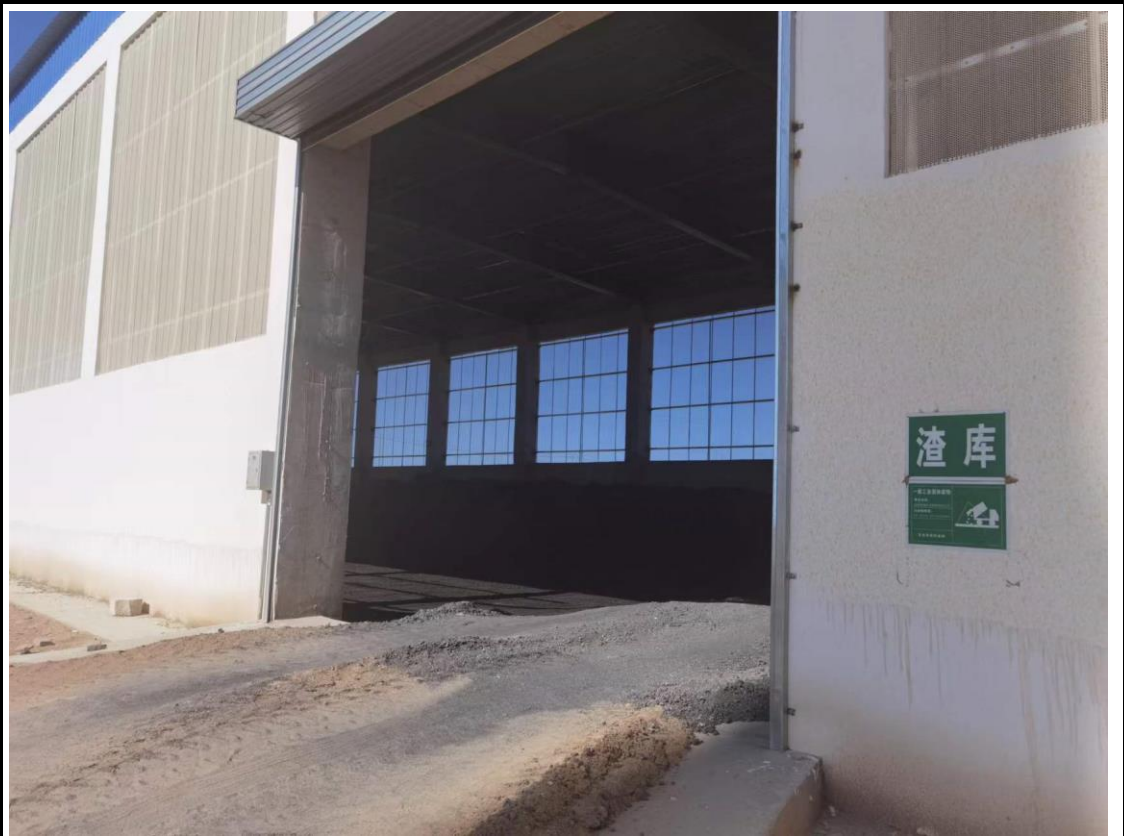
已建成的渣库
